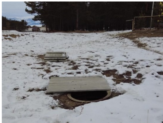
Рис. 2. Резервуары на острове Ольхон
