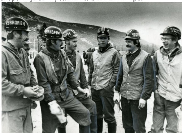
Фото 14. На укладке «золотого звена» машинисты-путькладчики Л. Бердников, В. Дудников, П. Колмаков. Фото Ф. Пилюгина. Станция Куанда. 1984 г.
