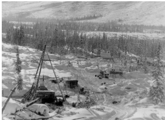
Фото 2. БАМ. Поселок геологов «Центральный» на Северо-Муйском тоннеле. На переднем плане буровая, с помощью которой исследуются породы по оси тоннеля. Витимская геопартия Багдаринской экспедиции. Февраль 1975 г.
