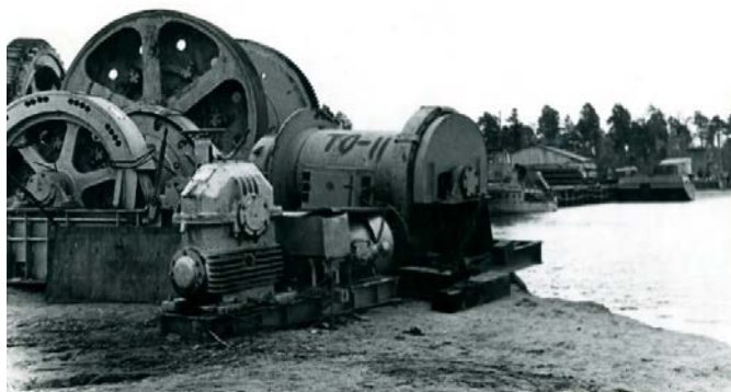
Фото 5. Старый Уоян. Оборудование для тоннельного отряда № 11. Автор А. М. Куртик. г. Северомуйск. 1976 г. ГАРБ. ФР. 1967. Оп. 1. Д. 228. Л. 8 об., фото № 18
